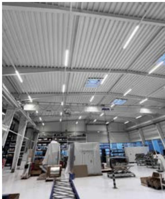
*Durch den Umstieg auf moderne LED-Leuchten sparen wir in unseren Produktionshallen beeindruckende 35 % Energie – ein weiterer Schritt in Richtung Nachhaltigkeit!*
